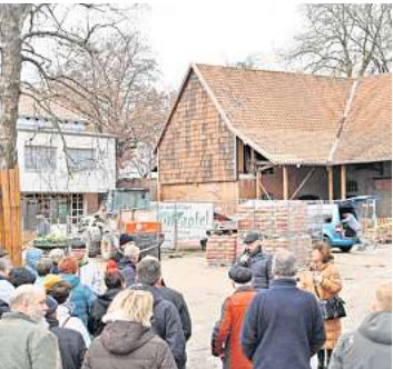
Die Dismer-Scheune soll erhalten bleiben: Rund 100 Menschen sind der Einladung einer Initiative zur Demonstration in der Thiestraße gefolgt. FOTO: TORSTEN LIPPELT
