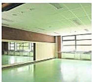
Der Gymnastikraum wurde energetisch gedämmt. Dafür wurde eine neue Fensterfront eingesetzt.
