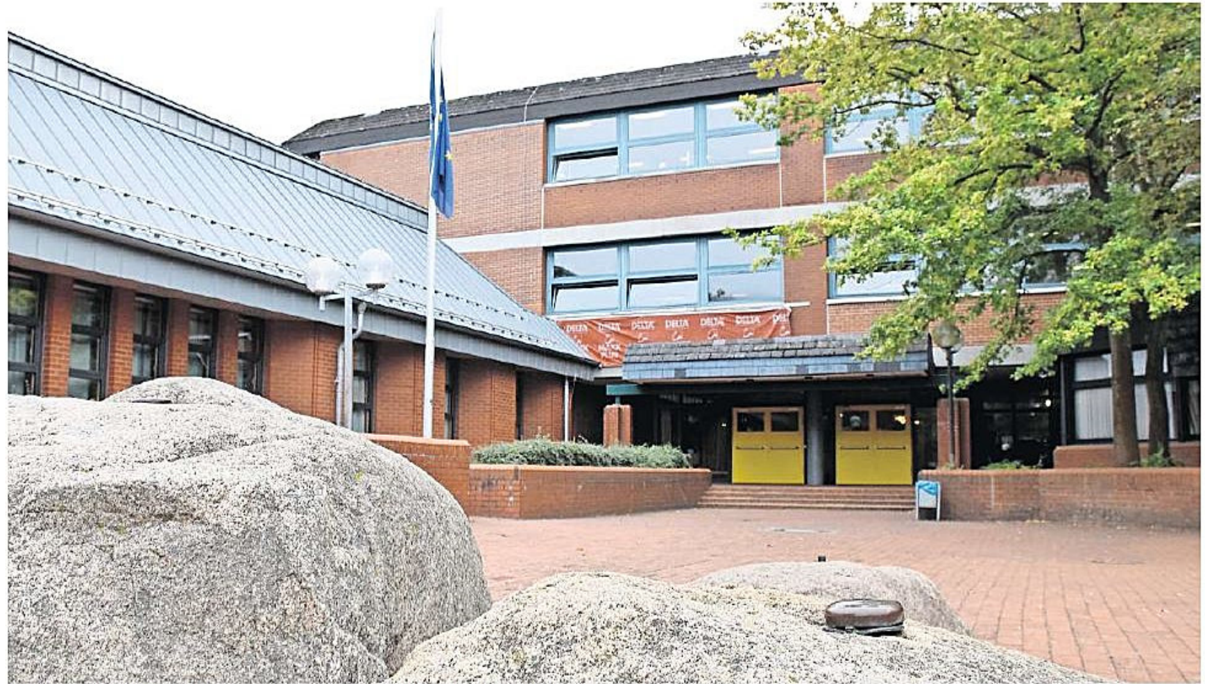
Das Erich-Kästner-Schulzentrum soll zum großen Teil abgerissen und neu gebaut werden.
